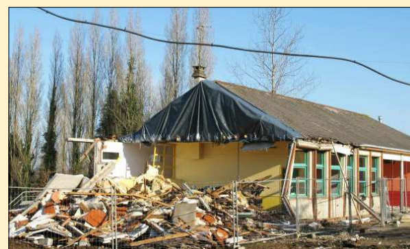
Démolition de l'école du Talhouet (Hennebon) : Le conducteur de la pelleuse a découvert que les ardoises étaient en amiante.
