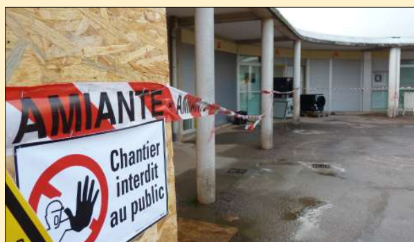
Ecole de Saint-Hilaire du Breithmas : 150 enfants déménagés dans des locaux provisoires pendant les travaux de désamiantage.
